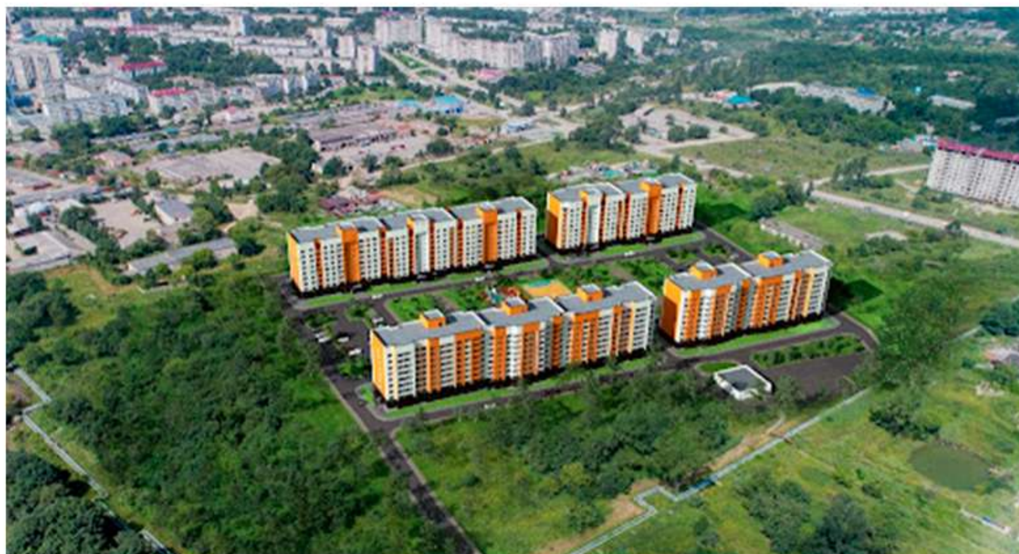
ЖК «СОЛНЕЧНЫЙ», БОЛЬШОЙ КАМЕНЬ Электромонтажные работы, пожарная сигнализация
