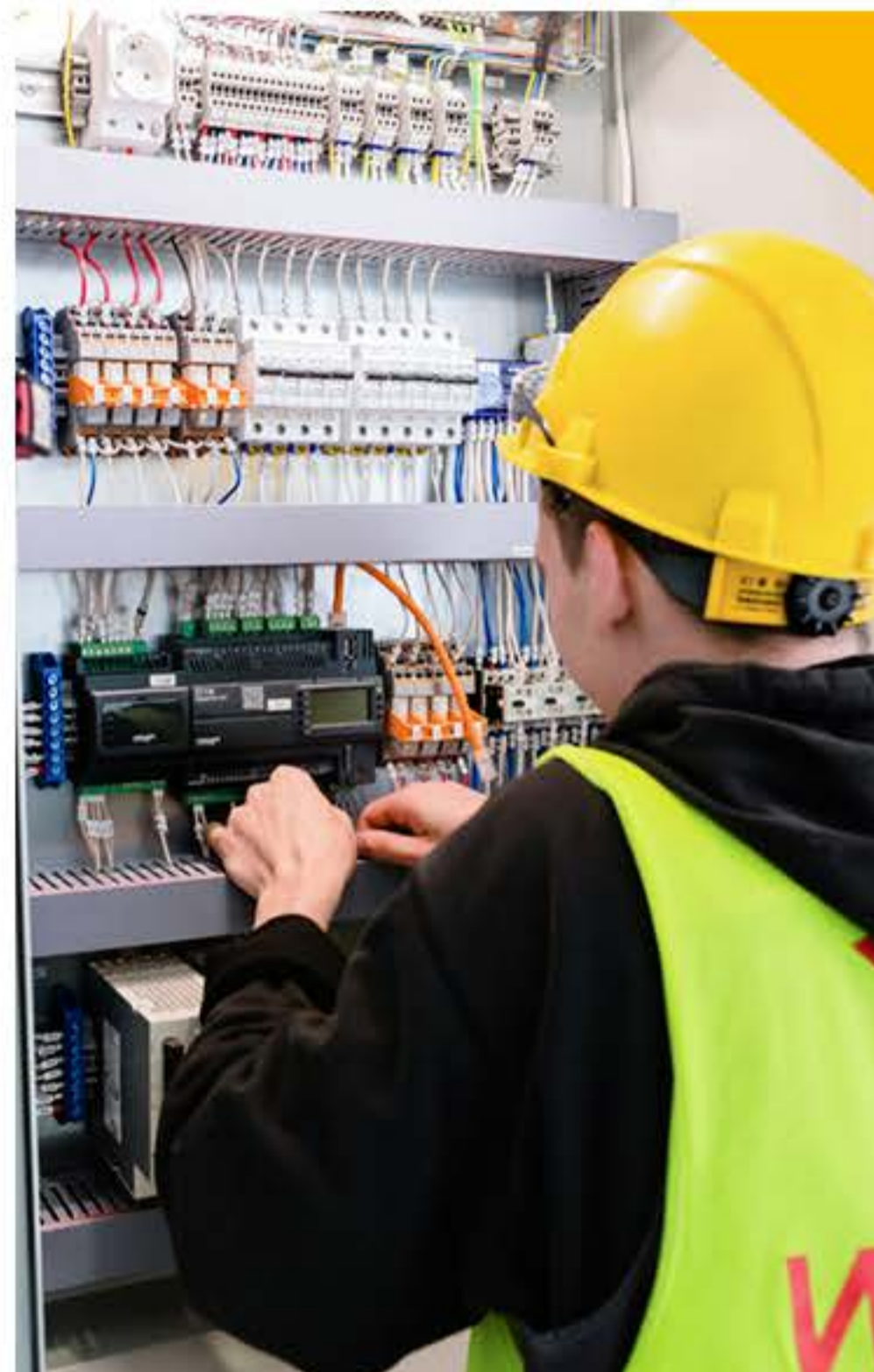
Монтаж слаботочных систем
