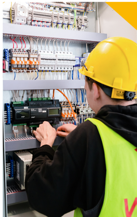
Монтаж слаботочных систем
