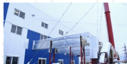
Котельная, г. Поронайск
