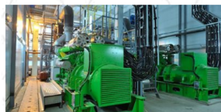
Котельная №79, г. Владивосток
